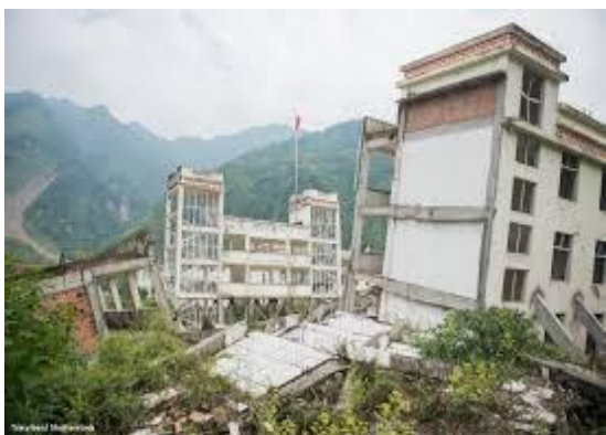
Figura 6 - Crolli edifici Corea del Sud
